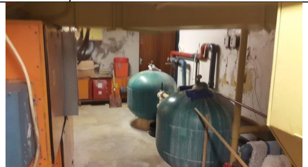
Bilde 4: Kloranlegg og bassengvegg
