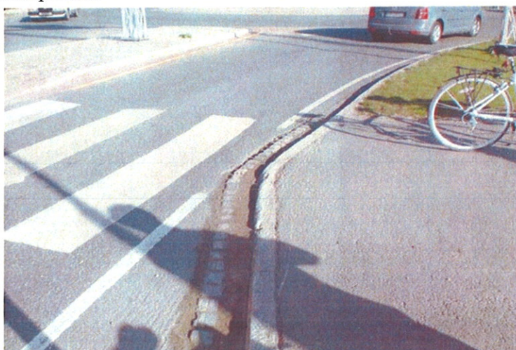
Asfaltkant på overgang ved Sortland bru
