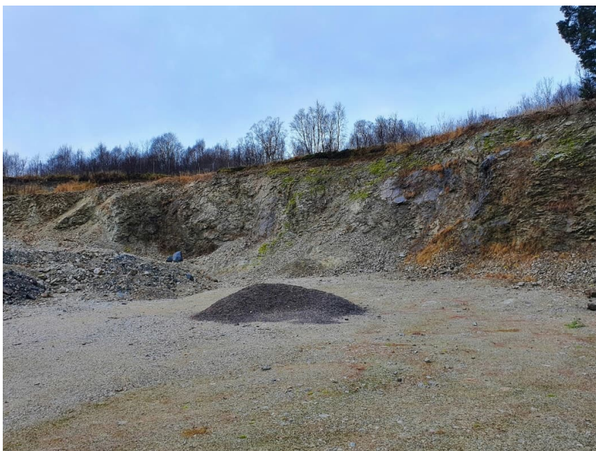
Figur 4. Eksisterende bergsjæring. Bildet er tatt mot nordvest.
